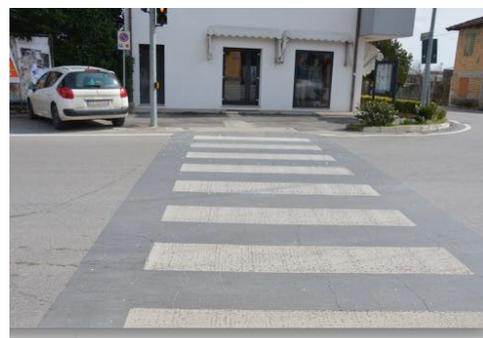
*Vernice con microsfere rifrangenti e semaforizzazione*
